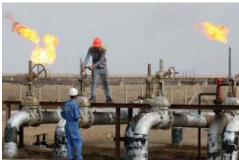
3 Punëtorë duke mirëmbajtur një tubacion naftë
