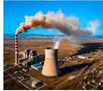
Fig. 2 Termocentrali "Kosova B"
