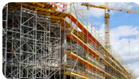
Fig. 2 Objekt në ndërtim
